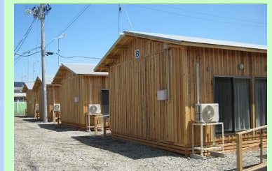
木造仮設住宅（設置例）
