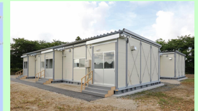
プレハブ住宅（設置例）
